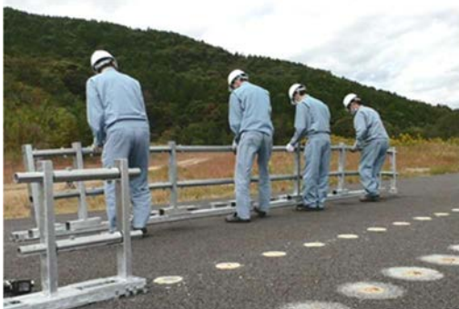
センターパイプ(部材取外し後)
