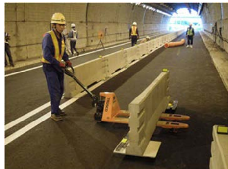
センターブロック(ハンドリフト使用)
