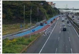
合流部の渋滞緩和のため横浜町田ICの加速車線を延伸しました。さらに、2車線ランプを分離型としスムーズな加速を可能とするためカラー舗装を施工しました。
