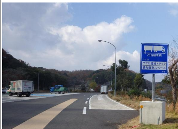
写真-1 E2A 中国道 江の川PA(下り線)
