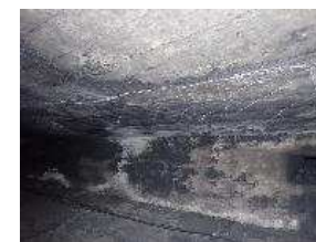
床版下面の鉄筋露出
