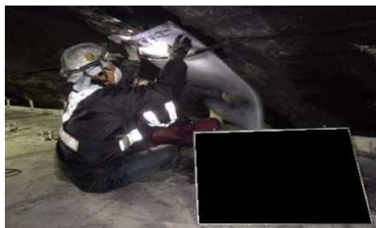
漏水防止シート取付
