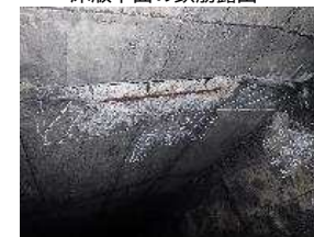
床版下面の鉄筋露出
