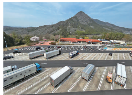
駐車マス拡充(中国道 安佐SA(上))
