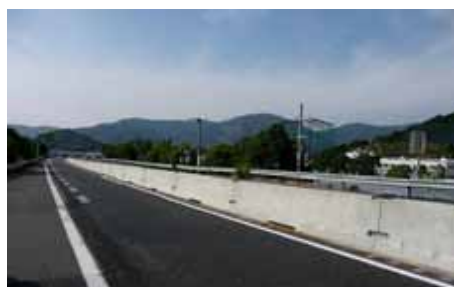
：プレキャストコンクリート防護壁(延長約2km)
