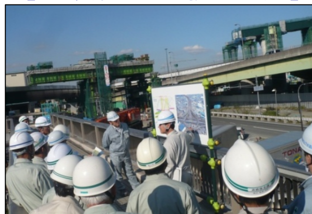
道路の建設現場
