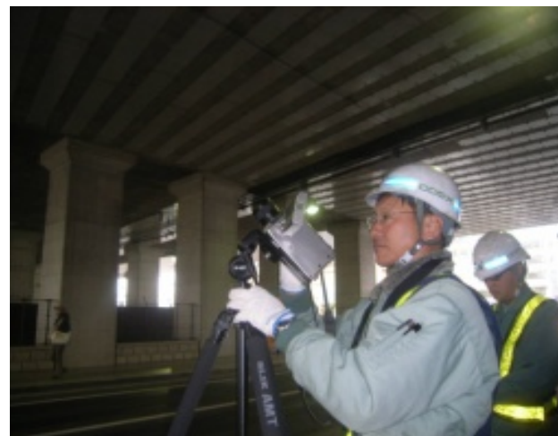
橋梁の維持管理
