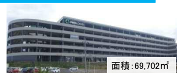
◆ 京田辺市の物流拠点施設 (平成30年11月竣工)
