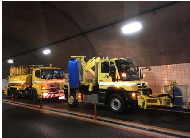
《トンネル側壁清掃》
