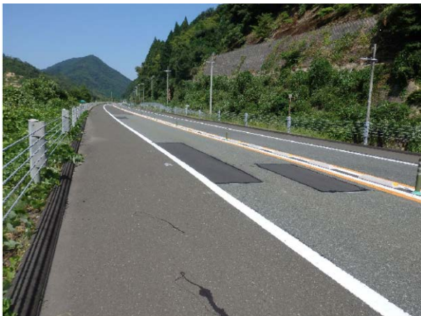
《舗装損傷状況》
