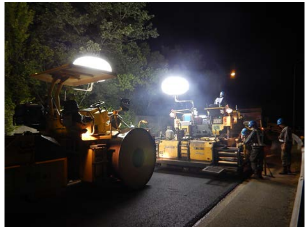
《舗装補修施工状況(イメージ写真)》
