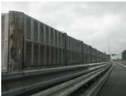
遮音壁老朽化状況
