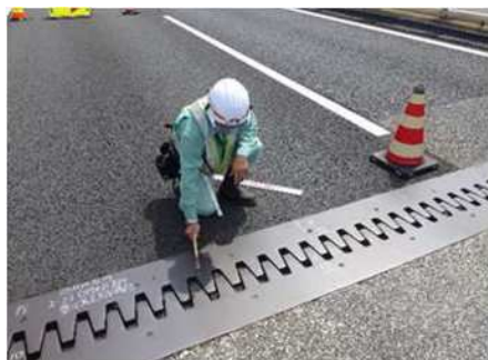
橋梁伸縮装置の点検
