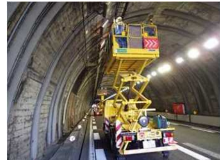
トンネル照明の点検
