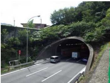
樹木繁茂状況
