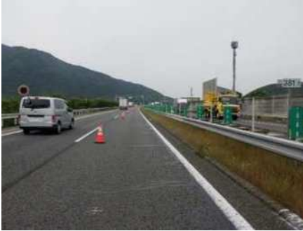
舗装損傷状況
