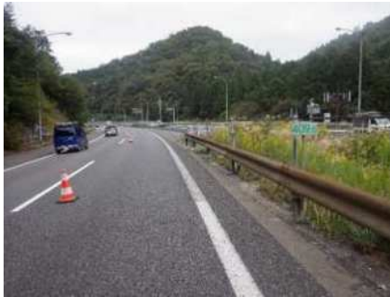
防護柵老朽化状況
