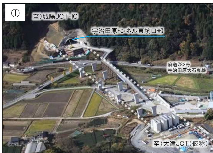
宇治田原トンネル東坑口部の整備状況 (2021年11月撮影)
