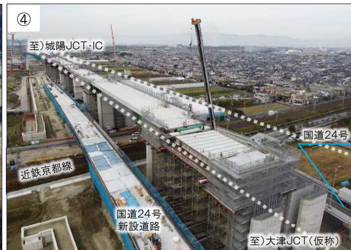
城陽高架橋部の整備状況 (2021年11月撮影)
