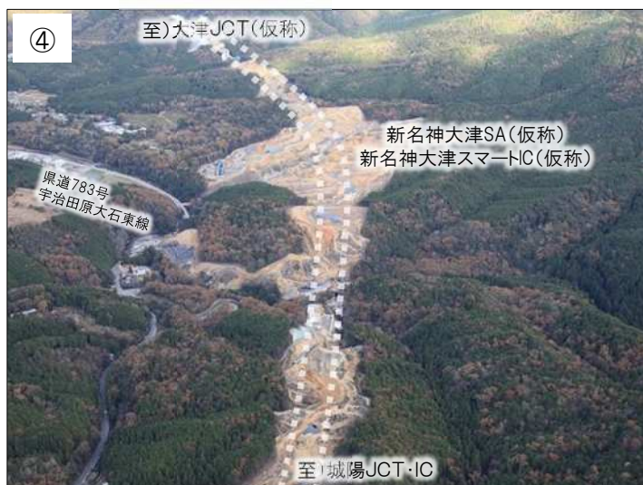
山間部(大石地区)の整備状況 (2021年11月撮影)
