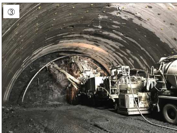
大津大石トンネルの整備状況 (2021年11月撮影)
