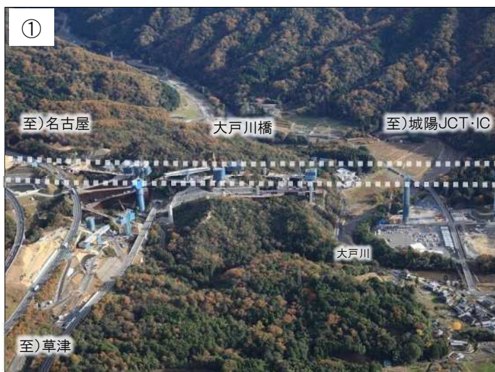
大戸川橋の整備状況 (2021年11月撮影)
