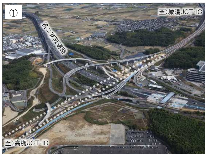
八幡京田辺JCT・ICの整備状況 (2021年11月撮影)
