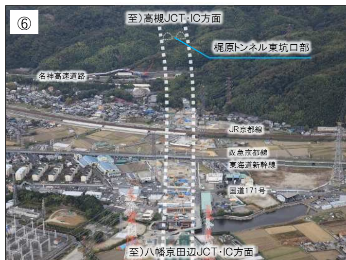
重要幹線交差部の整備状況 (2021年11月撮影)
