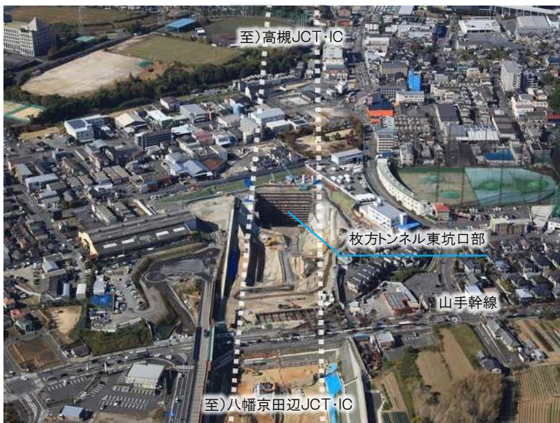
枚方トンネル東坑口部付近
