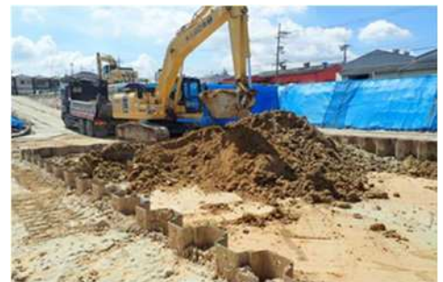
土壤汚染対策法に基づく作業を追加
