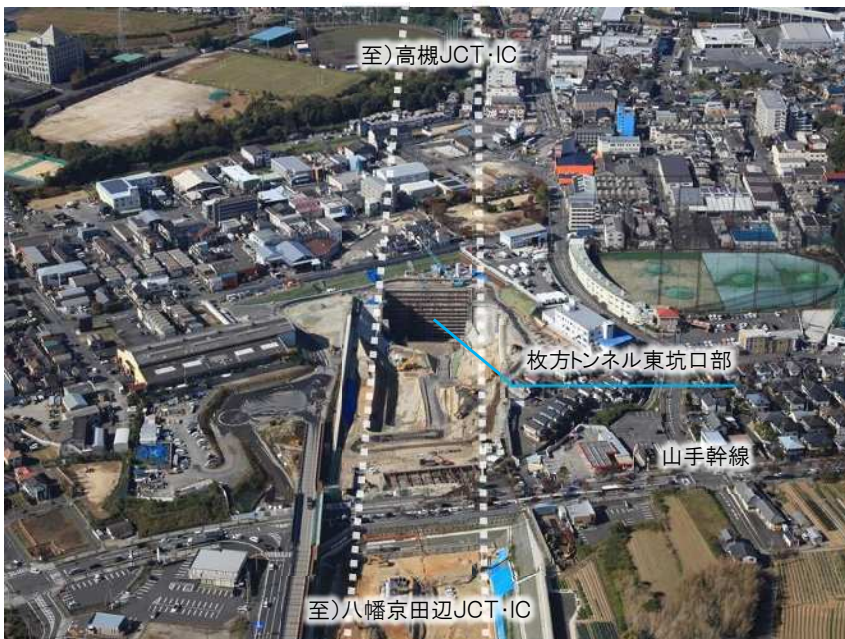
枚方トンネル東坑口部付近
