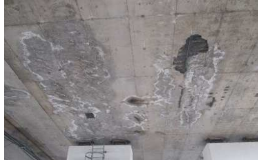
床版下面の損傷状況
