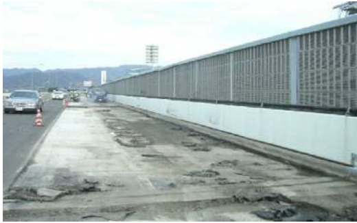
床版上面の損傷状況
