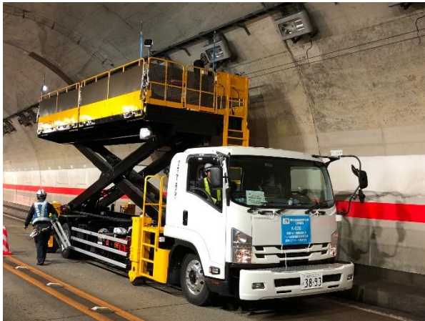
《設備清掃・点検》
