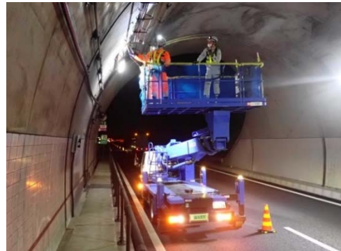
トンネル設備の点検
