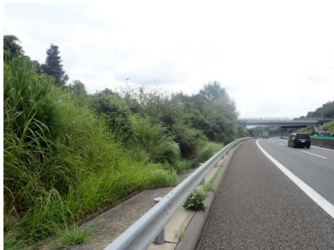
樹木繁茂状況
