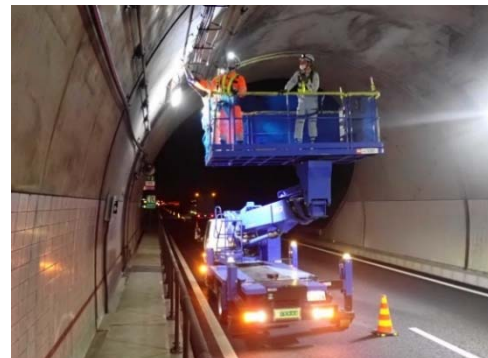
トンネル設備の点検
