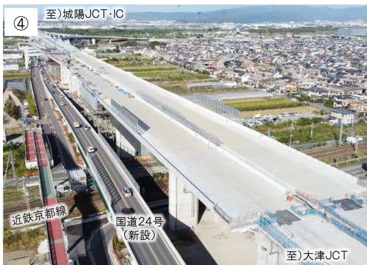
城陽高架橋の整備状況
