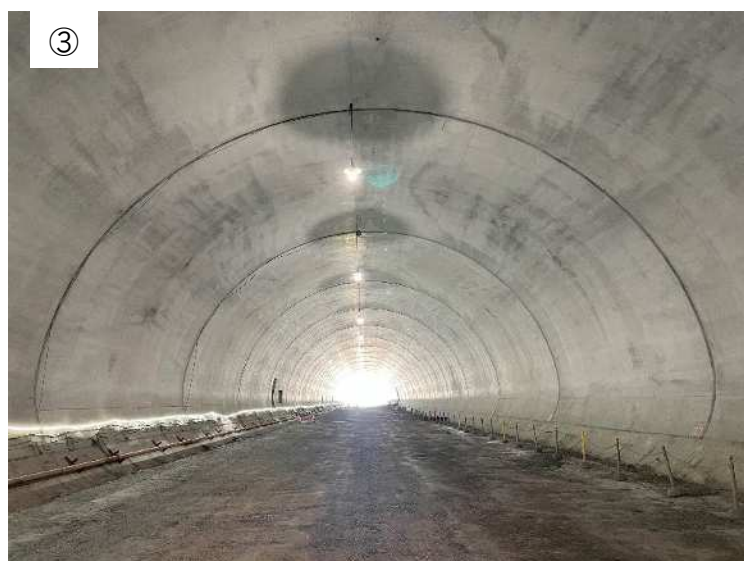
大津大石トンネルの整備状況
