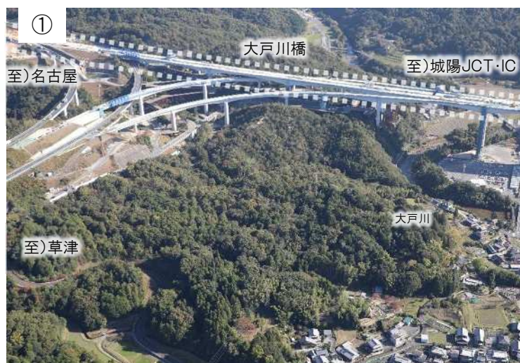
大戸川橋の整備状況
