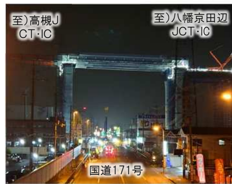
国道171号架設後
