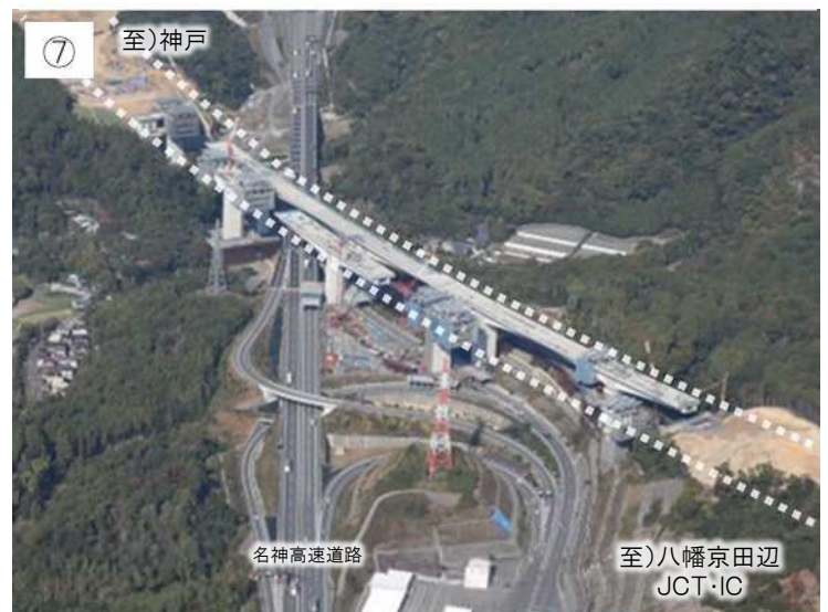
高槻JCT・IC付近の整備状況
