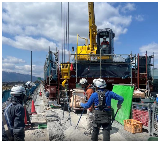
床版取替工事の様子
