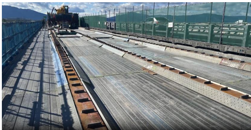
床版取替工事の様子
