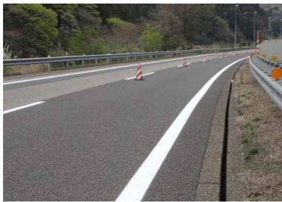
路面標示工の施工(イメージ)
