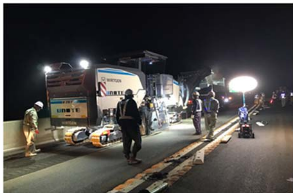
傷んだ舗装撤去状況(イメージ)
