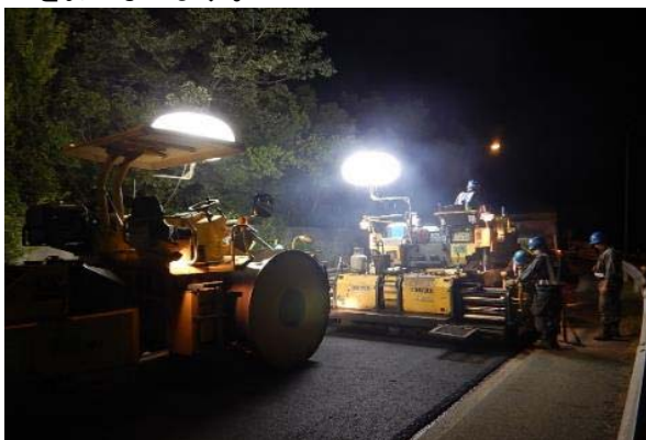
路面損傷箇所の補修(イメージ)
