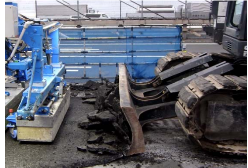
既設舗装の撤去
