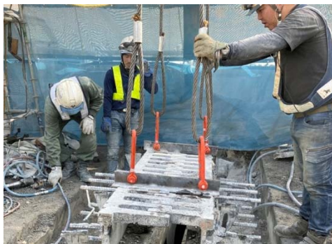
既存の橋梁伸縮装置を撤去
