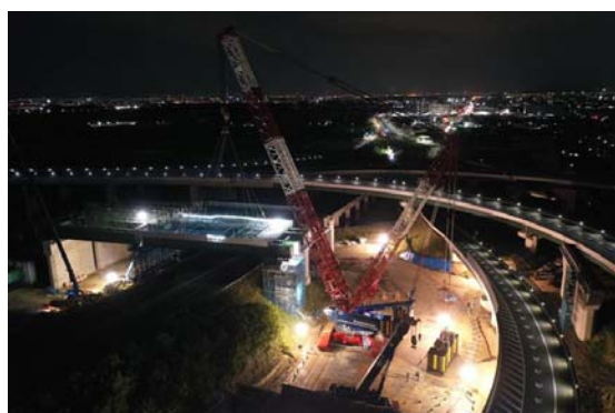
橋梁の桁架設状況
