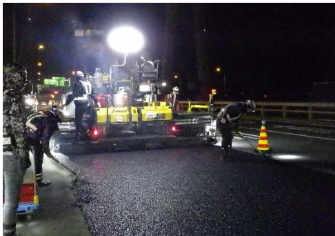
新しい舗装の舗設
