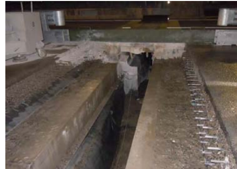
橋梁伸縮装置の撤去後の状況
