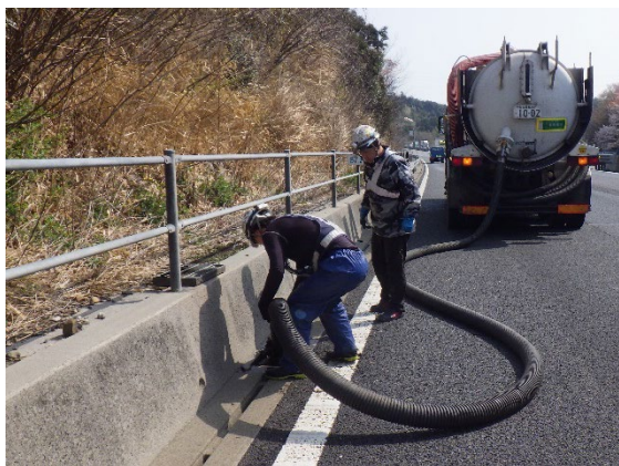
排水溝の清掃
