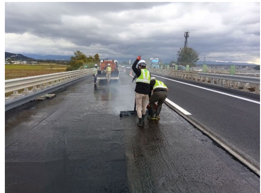
床版防水工の施工状況
