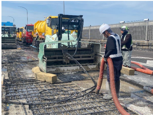
老朽化した床版の補修状況
