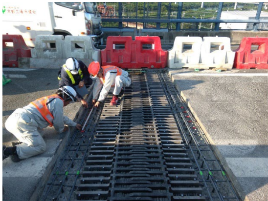
橋梁伸縮装置取替状況
