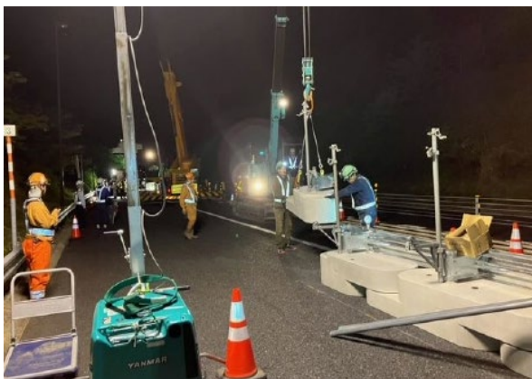
仮設防護柵設置(イメージ)
