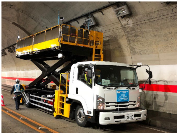
設備点検・清掃(イメージ)
