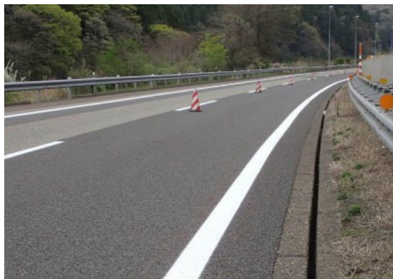
路面標示工の施工後(イメージ)
