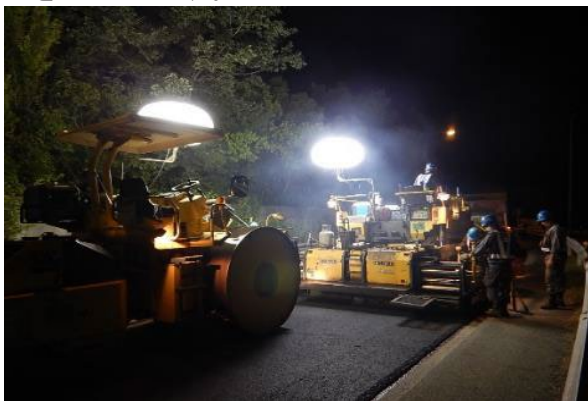
路面損傷箇所の補修(イメージ)
