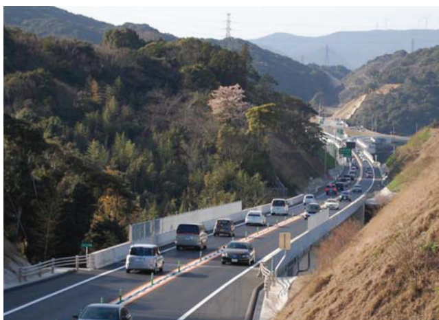
相浦中里インターチェンジと弓張トンネル間の状況
