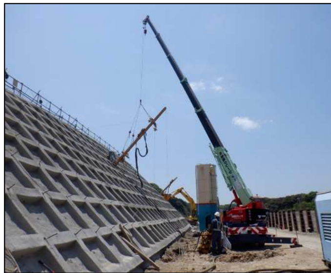
④鉄筋挿入工施工状況
