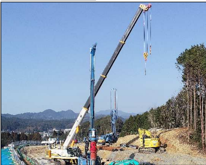
③鋼管杭施工状況
