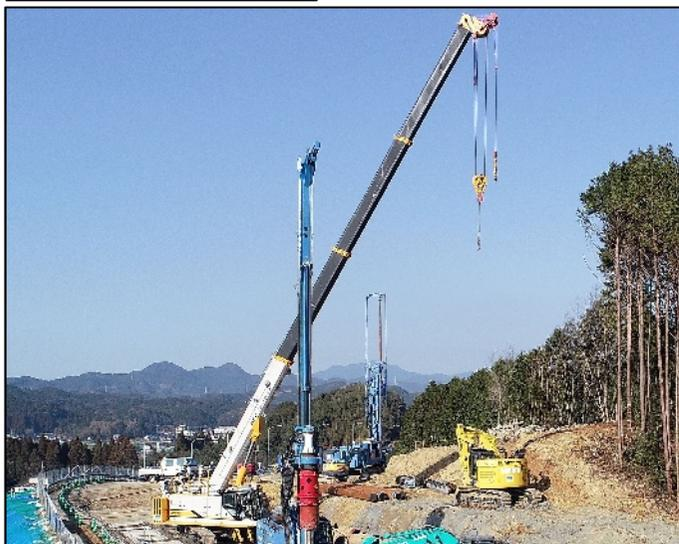
鋼管杭の施工には、杭打ち機械を1台から2台に増台することで、工程を短縮。
