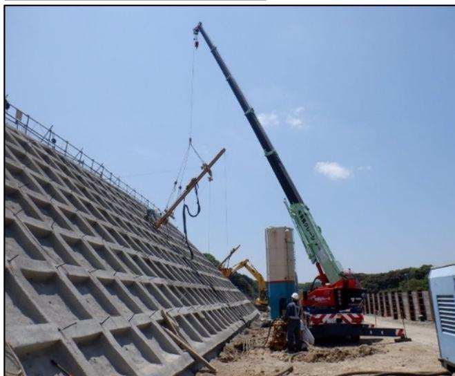
鉄筋挿入工の施工には、足場の設置・撤去が不要となるスライドリル工法を採用することで、工程を短縮。
