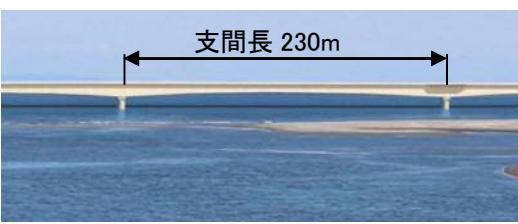
橋脚による流況への影響(地形変化量)を最小とするために、桁橋の最大スパンを適用した鋼桁橋
