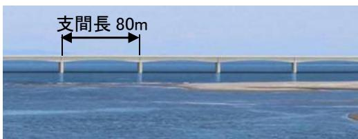
一般的に経済性に優れたスパンのコンクリート桁橋。(阿波しらさぎ大橋の一般部と同程度の支間長)
