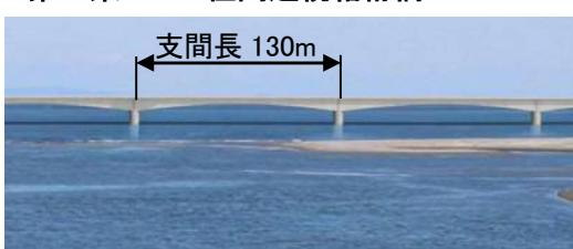
浚渫を最小とするために、橋桁架設時の浚渫が不要となる架設工法を採用し、その最大スパンを適用したコンクリート桁橋<sup>※2</sup>。
