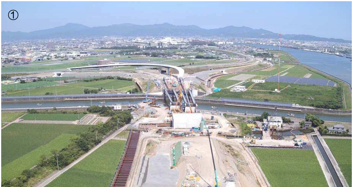
徳島JCT付近
