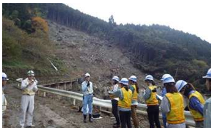
災害現場視察（高知自動車道）
