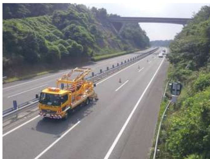
ロボコーンによるラバーコーン設置の様子2
