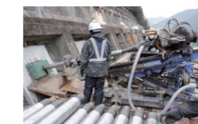
施工状況 (グラウンドアンカー)
