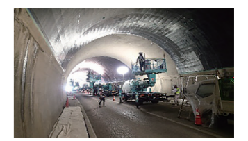
施工状況 (覆工補強)
