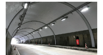
施工済状況 (覆工補強)
