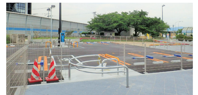
名神高速道路 桂川PA(上) ウェルカムゲート及び駐車場
