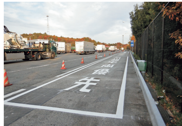
山陽道 三木SA(上) ダブル連結トラックマス整備状況
