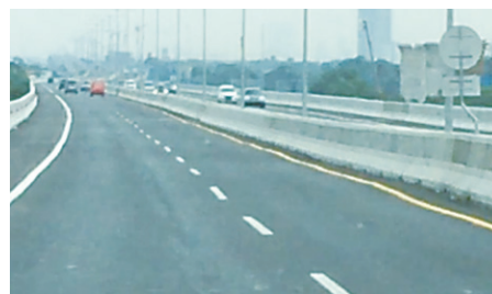
ジャカルタ～チカンベック高架有料道路(路面の状況)
