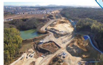
神戸西バイパス 樋谷工事
