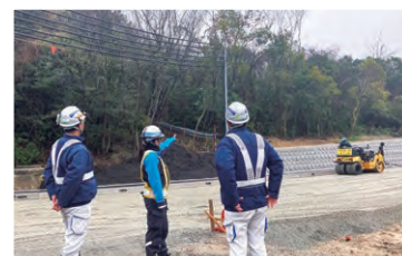
支障移転の現場打合せの様子
