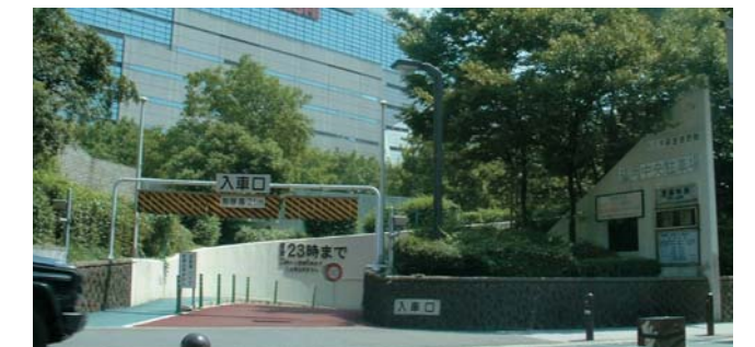
トラックターミナル: 2カ所、駐車場事業: 1カ所 占用施設(高架下)活用事業: 280カ所ほか (2008年7月現在)
