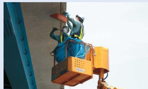
高所作業車上での橋梁たたき点検
