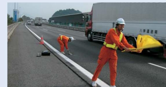
ポットホール（路面の凹凸）の緊急措置
