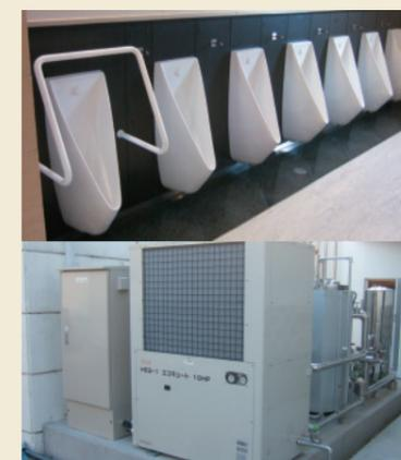
龍野面SAに設置した省エネ設備 (上) 節水型便器 (下) エコ給湯
