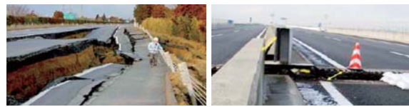
常磐道 水戸～那珂(上り線) 道路本体・路面の崩落等2カ所 仙台東部道路 仙台港北～仙台東(上下線) 橋梁ジョイント部の損傷46橋 56カ所
