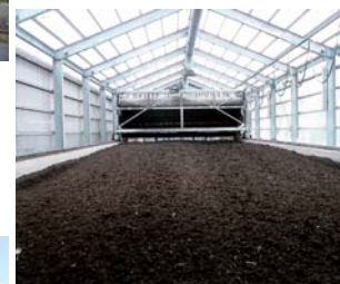
珉珠たい肥製造プラント (大分自動車道)
