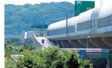
騒音を防止する遮音壁
