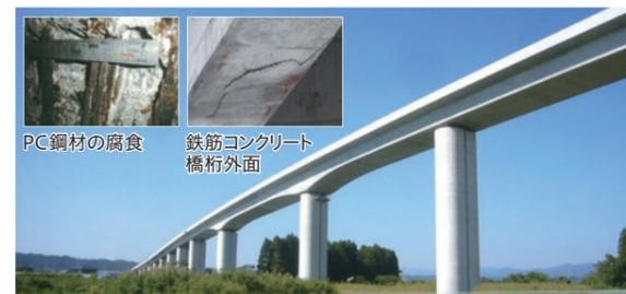
PC鋼材の腐食 鉄筋コンクリート橋桁外面
