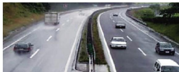
※ 高機能舗装: 車が巻き上げる水しぶきが減り視認性が向上するほか、すべり摩擦係数が高くなるため、雨天時の走行安全性の向上、交通事故の防止に有効な舗装。NEXCO西日本では、IRI値(「舗装路面の凸凹」に関する評価指標で、人間が感じる「乗り心地」に近い)などをもとに策定した舗装修繕計画に沿って導入を進めている(高機能舗装については、74ページも参照)。
