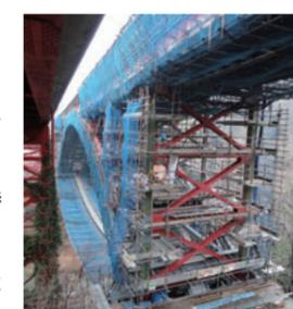
橋脚の耐震補強工事
