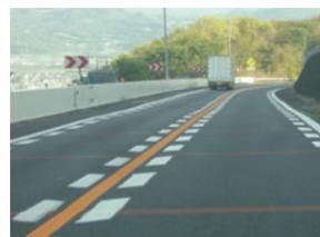
※ 薄層舗装: 舗装表面に塗装によるわずかな段差を設け、走行車両に振動を与えることで、漫然運転を抑制する注意喚起を行う。
