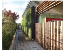
トイレの壁面は、植物を植えて緑化。建物の外から室内に入る熱や寒さを和らげて、冷暖房の使用量を抑えています。植物によるCO<sub>2</sub>吸収効果も。
