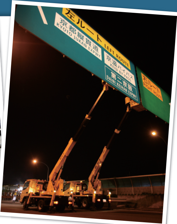
名神高速道路の集中工事の様子 (左：栗東IC付近での舗装補修工事、右：大山崎JCT付近での標識点検)
