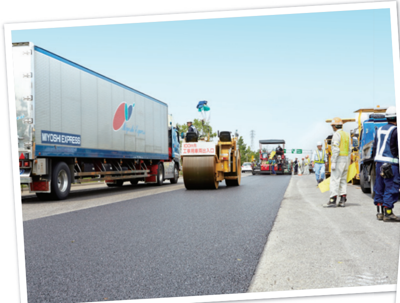
名神高速道路の集中工事の様子 (左：栗東IC付近での舗装補修工事、右：大山崎JCT付近での標識点検)
