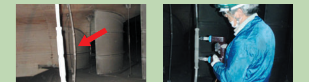
吊り金具14本の曲がり 磁粉探傷試験により健全性を確認
