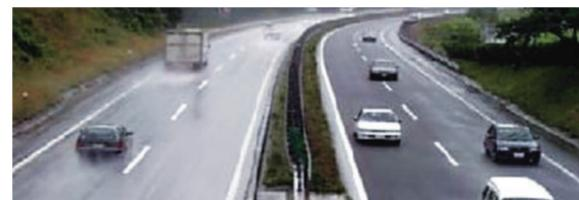
※3 高機能舗装:車が巻き上げる水しぶきが減り視認性が向上するほか、すべり摩擦係数 $\mu$ が高くなるため、雨天時の走行安全性の向上、交通事故の防止に有効な舗装。NEXCO西日本では、IRI値(「舗装路面の凸凹」に関する評価指標で、人間が感じる「乗り心地」に近い)などをもとに策定した舗装修繕計画に沿って導入を進めています。
