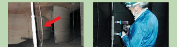
さらに、2012年12月7日に国土交通省から指示を受けた「トンネル内の道路附属物等の一斉点検」については、2012年12月26日までに重量構造物<sup>9</sup>である道路附属物の点検を完了しました。重量構造物以外の道路附属物も2013年3月末までに点検を完了し、点検した852トンネルのうち、19トンネルの一部の照明灯具取付部の腐食による欠損が確認されましたが、速やかに必要な措置を実施しました。
