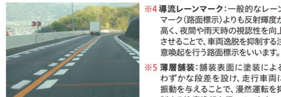
※4 導流レーンマーク:一般的なレーンマーク(路面標示)よりも反射輝度が高く、夜間や雨天時の視認性を向上させることで、車両逸脱を抑制する注意喚起を行う路面標示をいいます。
