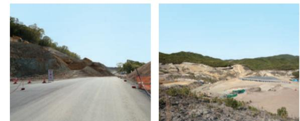
切土部で発生した土は、他の工事現場の盛土部で再利用します
