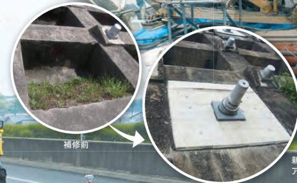
新型グラウンドアンカーによる補修後
