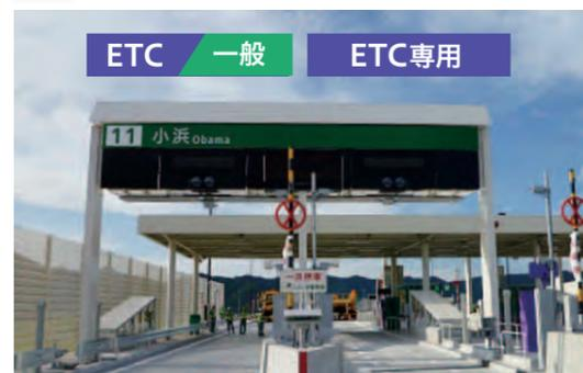
ETCレーンの複数化で、ETCサービスの休止時間を削減
