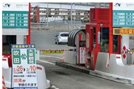
不正通行を防止する開閉バーを一般レーンにも設置
