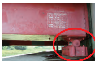
支承交換（左：施工前、右：施工後）
