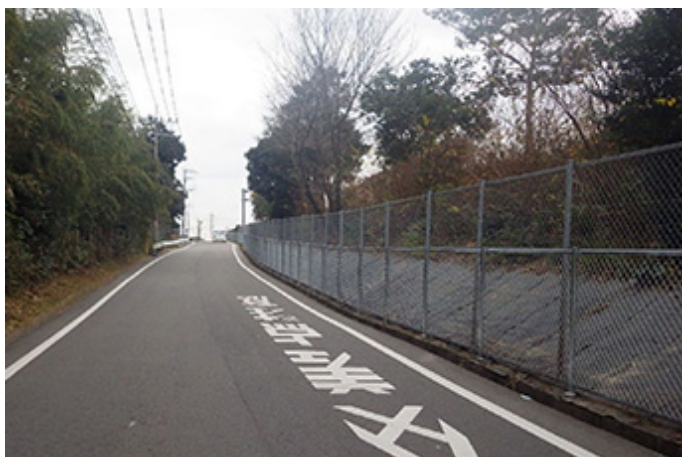
シカ侵入対策（フェンスの嵩上げ）
