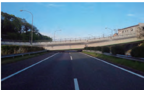
府領第一橋（落橋した直後の様子）
