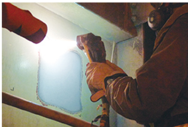
金属溶射作業の様子
