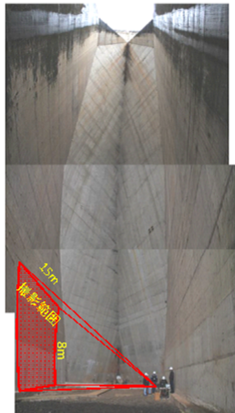
イタイプダム調査状況
