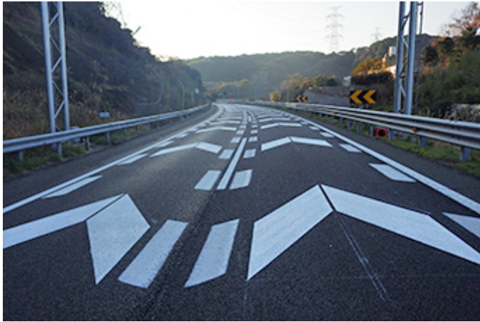
矢羽板や路面標示の施工例
