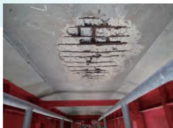
床版取替工事（左：施工前、右：施工後）
