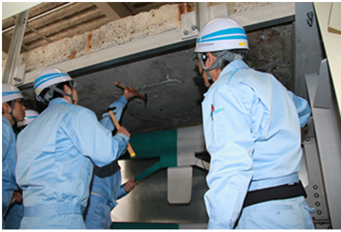
実構造物を活用した打音点検
