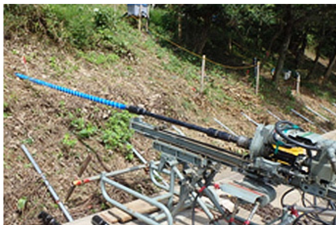
SDPR工法の施工状況
