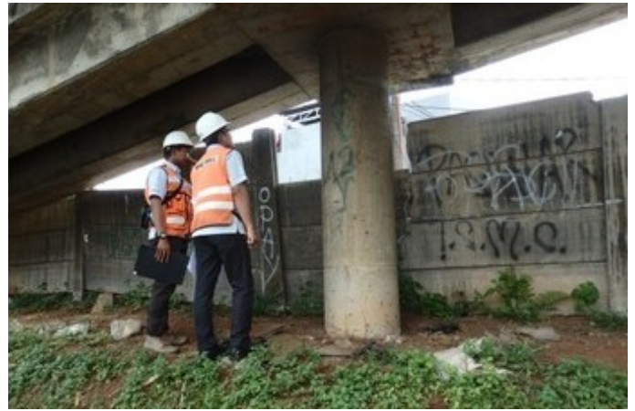
橋梁日常点検
