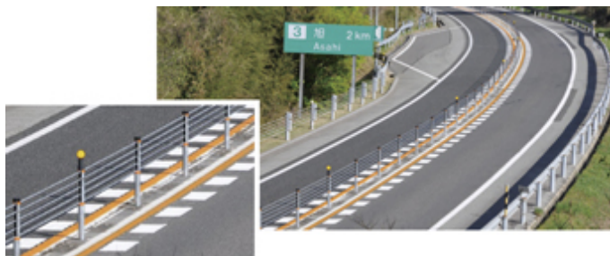
ワイヤロープの設置状況
