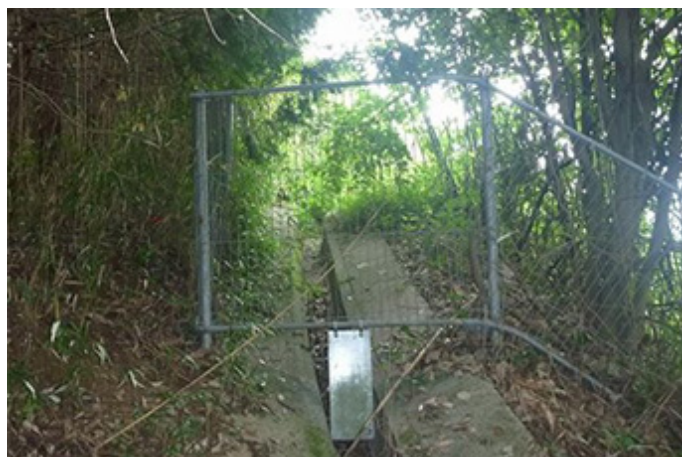
小中型動物侵入対策（排水溝の閉塞）
