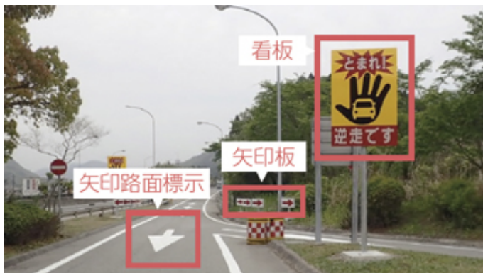
休憩施設入り口部での逆走対策例
