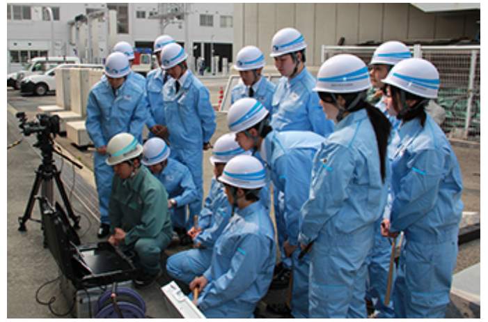
auto CIMA Systemによる撮影・診断
