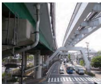
鉄道及び重交通路線と近接する区間
