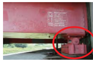
支承交換（左：施工前、右：施工後）
