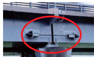
落橋防止装置設置（左：桁同士、右：橋台と桁）
