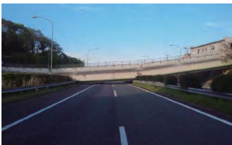
府領第一橋(落橋した直後の様子)
