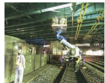
鉄道交差箇所における橋梁点検(イメージ)
