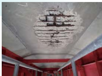
床版取替工事（左：施工前、右：施工後）
