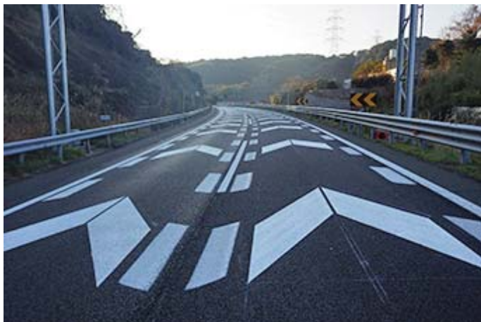
矢羽板や路面標示の施工例
