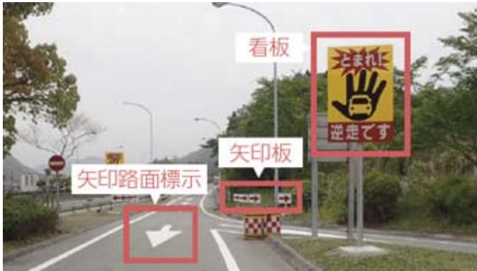
休憩施設入り口部での逆走対策例
