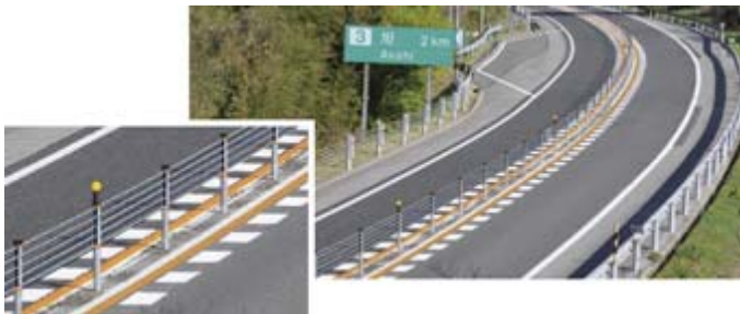
ワイヤロープの設置状況
