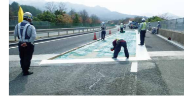
高性能床版防水施工状況
