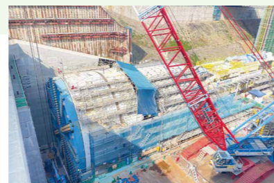
枚方トンネル掘削の準備工事
