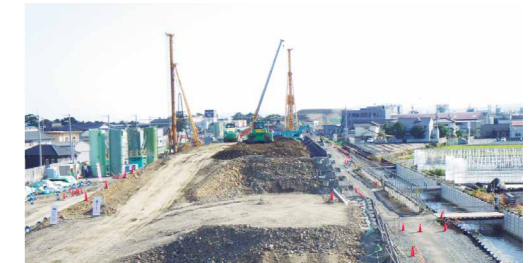
建設発生土の受け入れ
