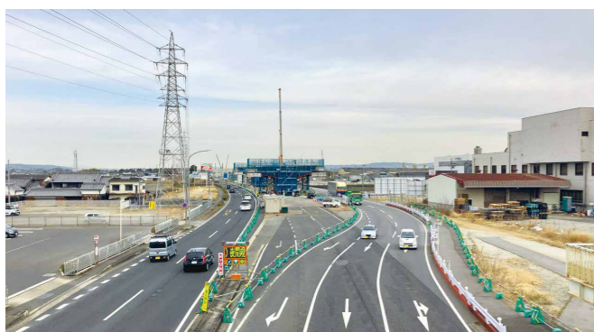
国道24号線交通規制状況
