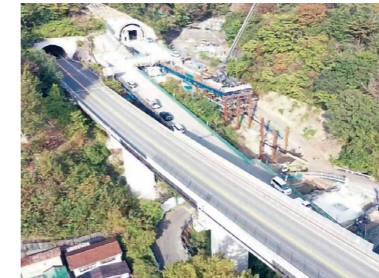
広島呉道路4車線化工事
