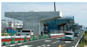
発志院北第一高架橋他1橋(下部工)工事
