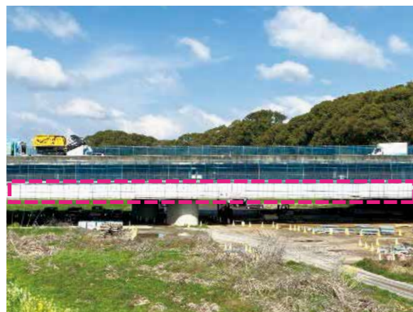
渇水期は作業スペースの高さを確保し効率化
