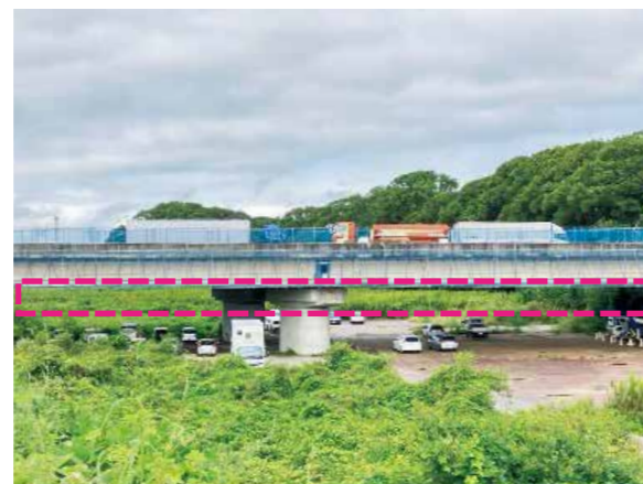
出水期は水位上昇に備え足場を高くし、工事を継続
