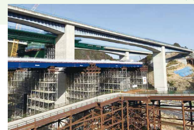
杉谷川橋(下)PC上部工事
