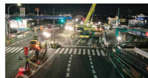
大江第一高架橋他4橋(下部工)工事
