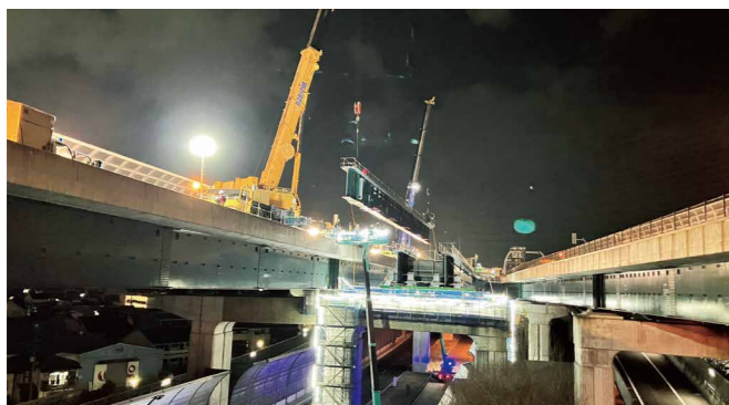
門真高架橋東(鋼上部工)設計・工事
