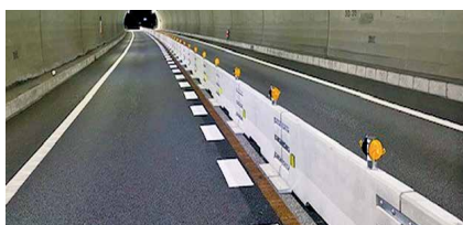
センターブロック
