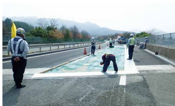
高性能床版防水施工状況
