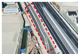
徳島南部道本線横の津波避難場所(赤枠内)
