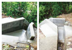
強化後の縦溝と集水ます
