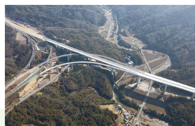
開通区間と接続する大津JCT
