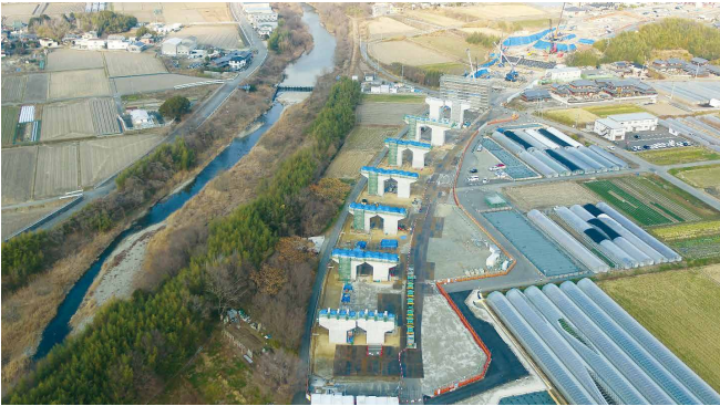
平野東高架橋他6橋(下部工)工事
