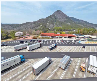
駐車マス拡充(中国道 安佐SA(上))
