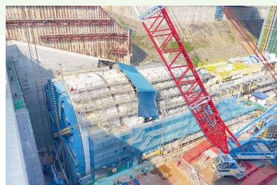
枚方トンネル掘削の準備工事
