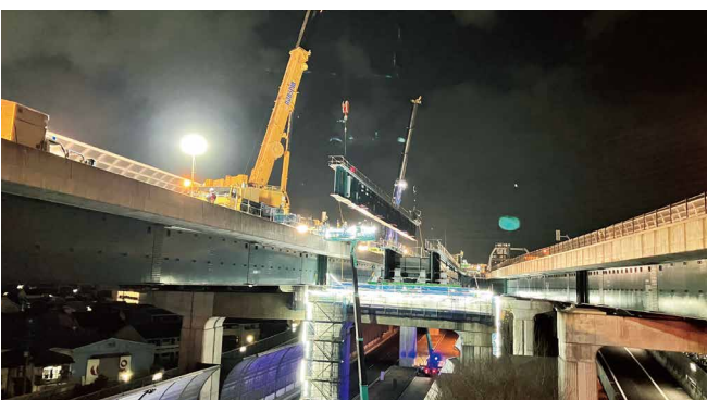
門真高架橋東(鋼上部工)設計・工事
