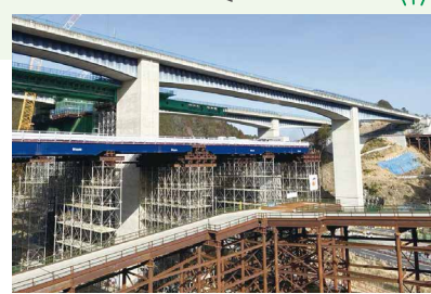
杉谷川橋(下)PC上部工工事
