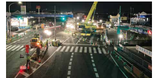
大江第一高架橋他4橋(下部工)工事
