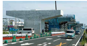
発志院北第一高架橋他1橋(下部工)工事
