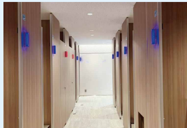
トイレのブースごとの案内ランプで、空きブースを分かりやすくご案内
