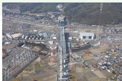
既設の鉄道・道路をまたぐ高槻高架橋
