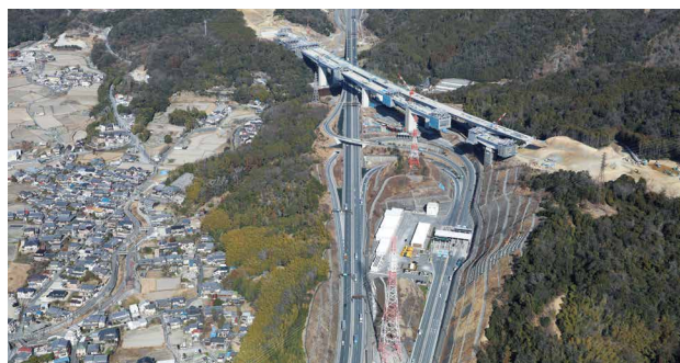
高槻JCT・IC～八幡京田辺JCT・ICの建設が進む 新名神高速道路 高槻JCT・IC付近
