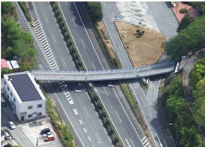
熊本地震で九州道を横架する県道が落橋
