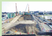
建設発生土再利用
