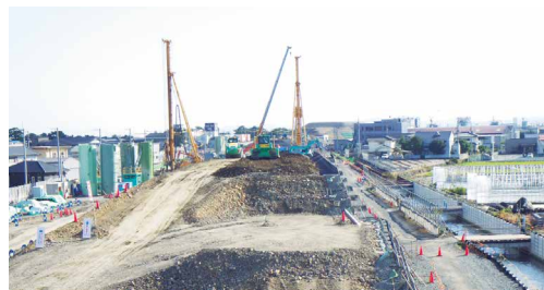
建設発生土の受け入れ
